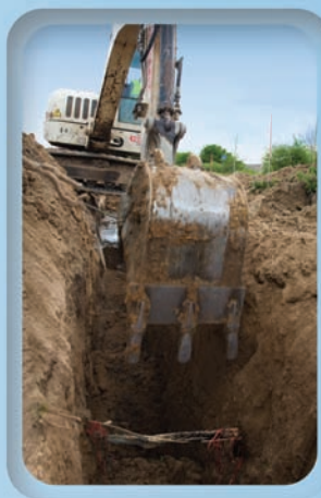
Réalisation d'une tranchée
