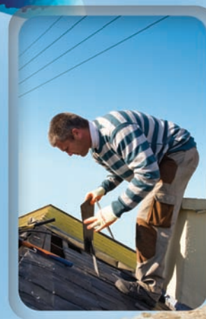
Peinture, couverture, manutention sur les toits
